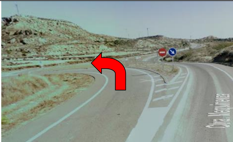
Carretera Mequinzenza cruce giro izquierda con N-211
